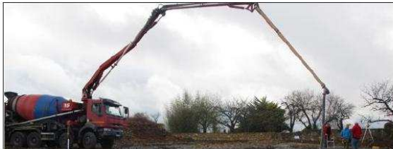
■ Les travaux de construction de la crèche se poursuivent. Photo Catherine LAPOSTOLET
