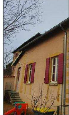
■ L'extension de la mairie est prévue au rez-de-chaussée des locaux actuels du multi-accueil qui jouxte la mairie. Photo Catherine LAPOSTOLET
