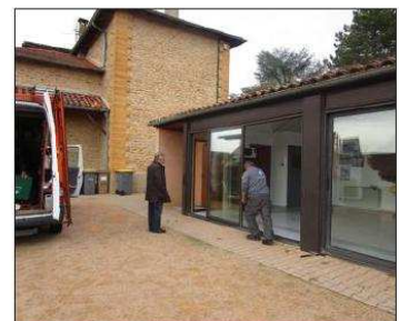
■ Les travaux de remise en état des baies vitrées de la salle du préau ont été réalisés. Photo Catherine LAPOSTOLET
