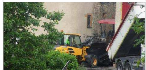
■ Les travaux de réfection de la voirie communale à la Chanaz sont terminés. Photo Catherine LAPOSTOLET.
